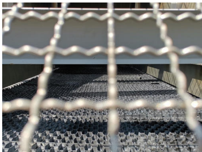
» Kapljični filter nameščen na hladilnem stolpu. | Vir: mycon
